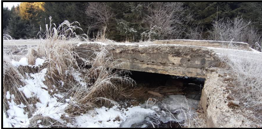
Foto 07. Situatia existenta pe DJ 153C
