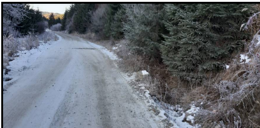
Foto 06. Situatia existenta pe DJ 153C
