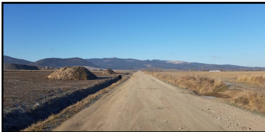
Foto 11. Situatia existenta pe DJ 153C
