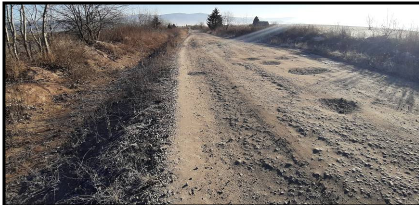
Foto 10. Situatia existenta pe DJ 153C
