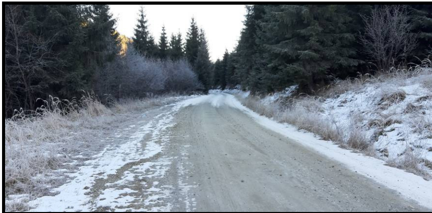
Foto 05. Situatia existenta pe DJ 153C
