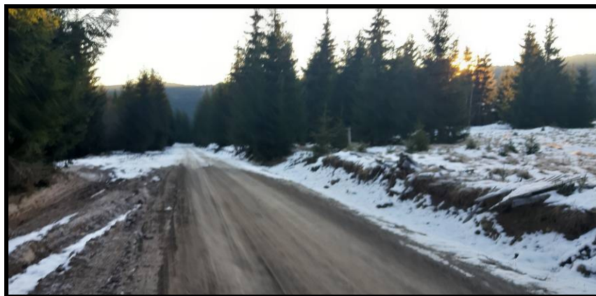
Foto 02. Situatia existenta pe DJ 153C
