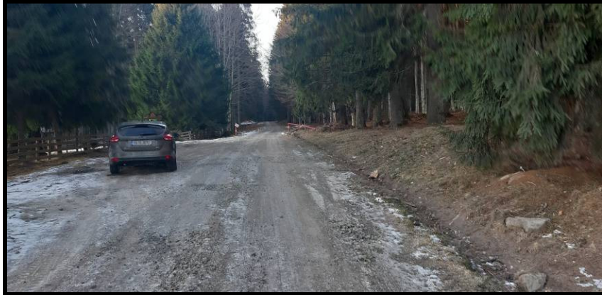
Foto 01. Situatia existenta pe DJ 153C
