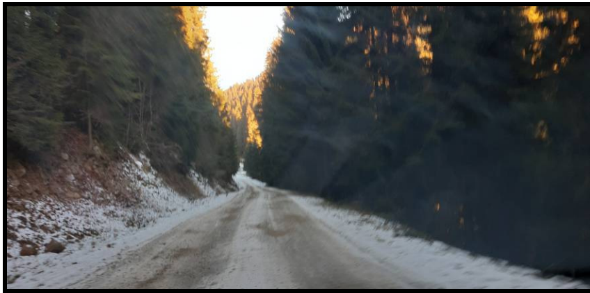
Foto 04. Situatia existenta pe DJ 153C
