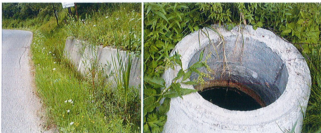
Fig. 5 Susținere taluz. Cămin de dren.
