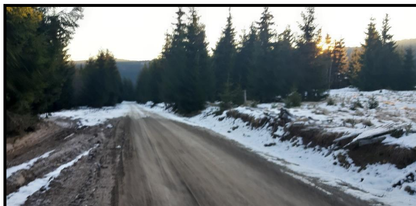
Foto 02. Situatia existenta pe drumul analiza
