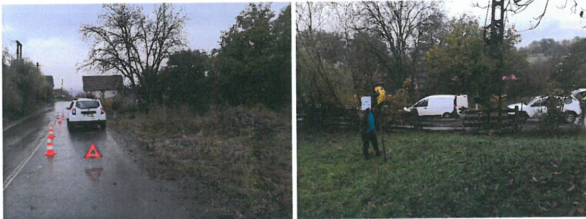
Figura 3.16. Realizare foraje Obiectiv 8
