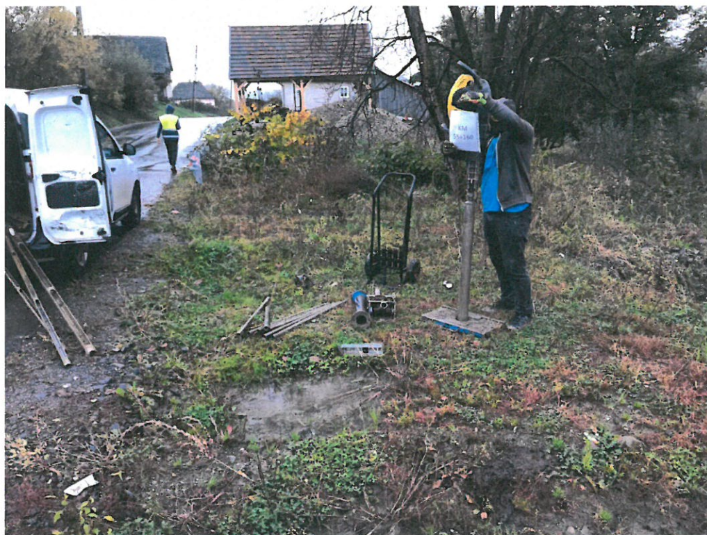
Figura 3.1 Aparatura folosita la realizarea studiului geotehnic
